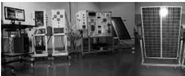
Figure 1 : vue complète du banc d'étude solaire
