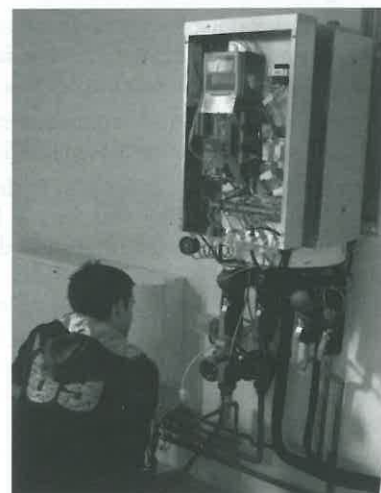
Régulation électronique et variation de vitesse sur pompe à chaleur
