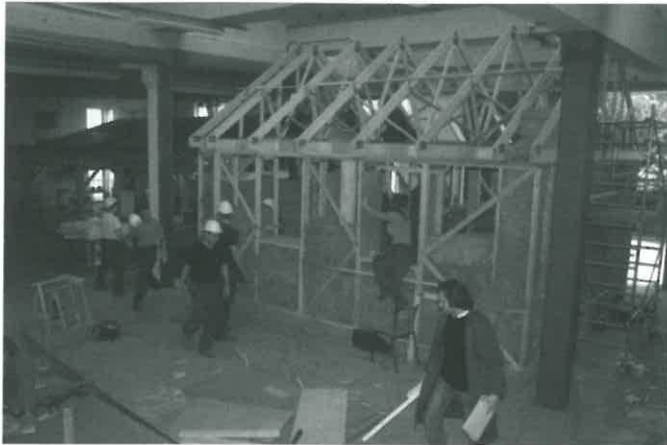
Maison en paille en construction
